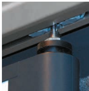
Galet emprisonné sur rail anti-déraillement.
