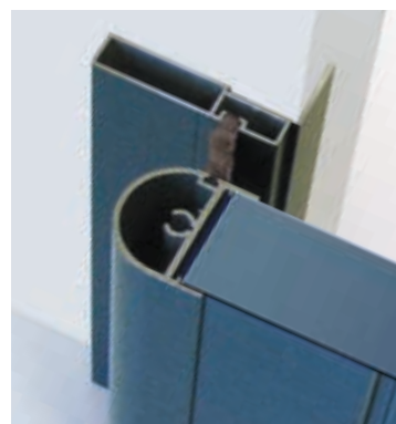
Joint lèvres sur le précadre et sur la porte et cornière d'habillage avec maçonnerie.
