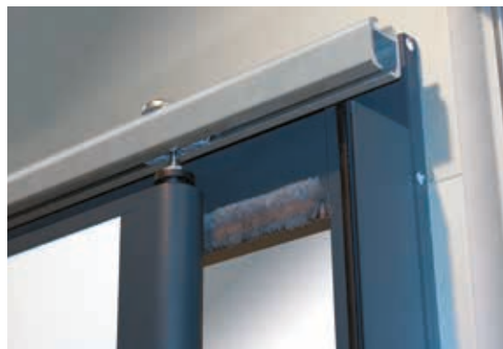
Précadre aluminium laqué + joint brosse et joint caoutchouc d'étanchéité.
