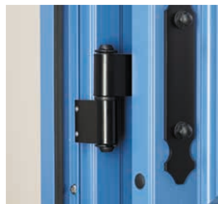
Détail montage gonds sur précadre.
