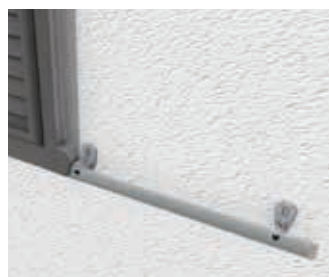
Réglette support en partie basse pour porte-fenêtre avec motorisation.
