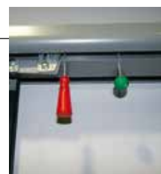
Débrayage manuel du moteur à l'intérieur du garage en cas de panne de courant
