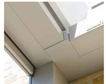
Évacuation des eaux via les gouttières placées dans les poteaux
